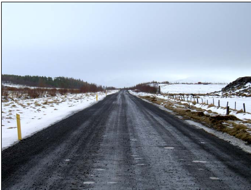
Mynd 1. Dagverðareyrarvegur. Mynd tekin til norðurs við stöð 3300 (SJ).
